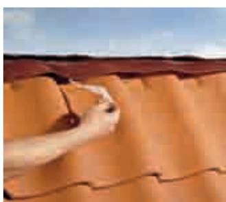
Le Quick-Fix est facile à appliquer. Il suffit de le dérouler et de libérer la bande adhésive. Le chevauchement des deux rouleaux doit toujours être de 50 mm.
