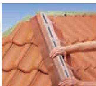
La bavette profilée en aluminium est comprimée uniformément dans le profilé des tuiles en terre cuite, des deux côtés du support.
