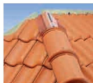
Les arêtiers ou faîtières sont posés au-dessus de la sous-faîtière en aluminium et sont fixés au moyen de vis en inox avec rondelle et bague d'étanchéité en néoprène (4,5 x 80 mm) et/ou d'un crochet pour faîtière spécial en aluminium.
