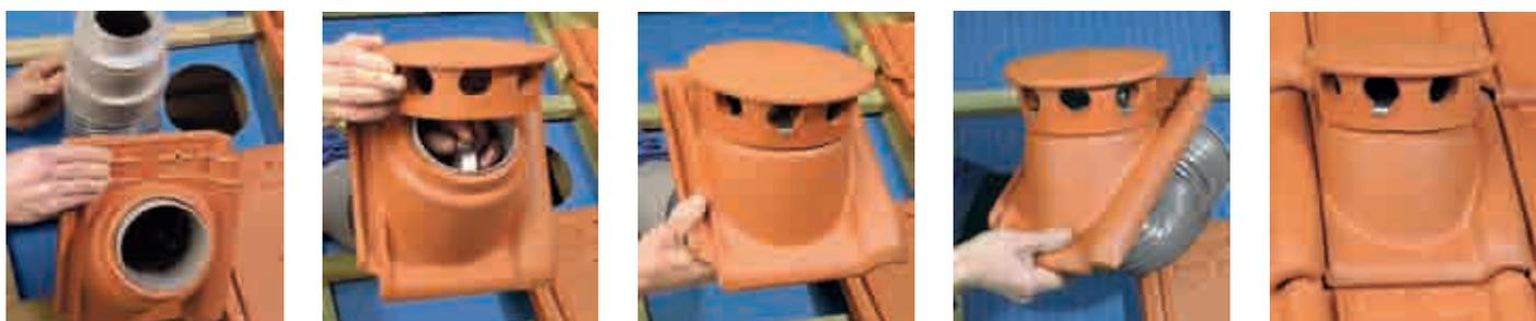
Introduisez le module et le réducteur dans la tuile à douille de sorte que le bord supérieur dépasse la tuile à douille de 5 mm environ. Faites passer les crochets de raccordement à travers le module. Posez le mitron sur la tuile à douille et fixez les crochets de raccordement. Posez enfin sur le toit la tuile à douille avec mitron.
