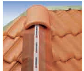
Les arêtières ou faîtières sont posés au-dessus de la sous-faîtière en aluminium et fixés au moyen de vis en inox avec rondelle et bague d'étanchéité en néoprène (4,5 x 80 mm) et/ou d'un crochet pour faîtière spécial en aluminium.
