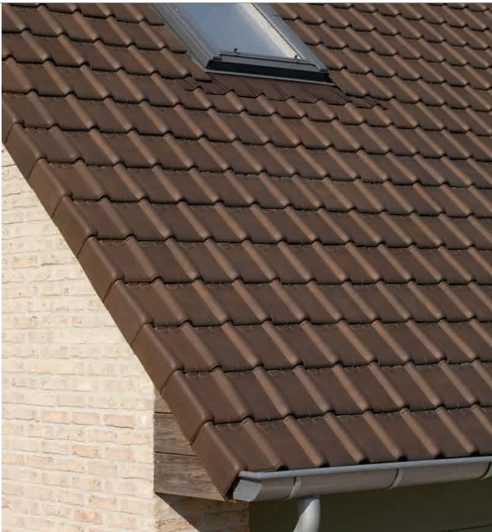
Tuile Tempête 44 vieux cuivre - fixation: des crochets de tuiles visibles
