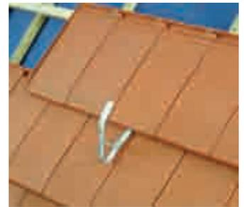
Pour fixer le crochet sûrement, il faut monter une planche de 38 x 200 mm débordant de 60 mm à gauche et à droite des chevrons. Pour la fixation aux chevrons, on utilise 10 clous de 38 x 110 mm (5 clous par chevron).
