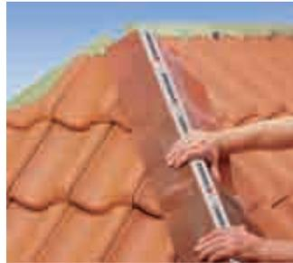
La bavette profilée en plomb est comprimée uniformément dans le profilé des tuiles en terre cuite, des deux côtés du support.
