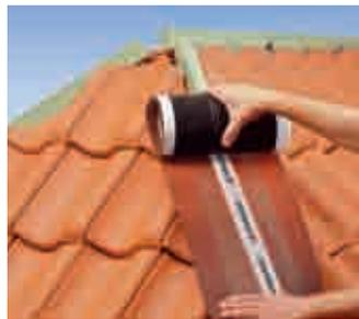
L'Alu-Rol est déroulé sur la latte d'arête ou de faîte et est fixé au moyen de clous à tête plate, d'agrafes ou de vis. Le chevauchement des deux rouleaux doit toujours être de 50 mm.
