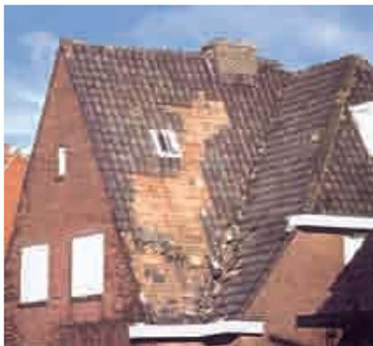
L'ancrage ou la fixation mécanique sont souvent nécessaires et ne peuvent pas être omis. En effet, nous sommes de plus en plus confrontés à des tempêtes accompagnées de vents de grande vitesse. Il serait incorrect de dire que les tuiles seules doivent être capables de résister à ces forces de la nature. Eurocode 1 nous permet de déterminer dans quelle mesure les tuiles doivent être fixées.
