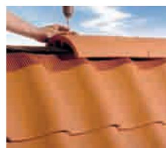
Les arêtiers ou faîtières sont posés au-dessus de la sous-faîtière en aluminium et sont fixés au moyen de 2 vis en inox à rondelle et anneau en néoprène (4,5 x 80 mm).
