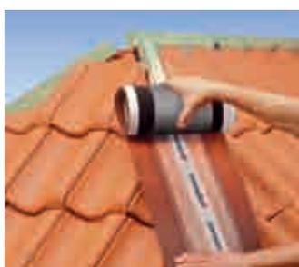
Le Flexi-Rol est déroulé sur la latte d'arêtier ou de faîte et est fixé au moyen de clous à tête plate, d'agrafes ou de vis. Le chevauchement des deux rouleaux doit toujours être de 50 mm.
