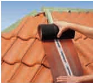
Le Grafi-Rol est déroulé sur la latte d'arêtier ou de faîte et est fixé au moyen de clous à tête plate, d'agrafes ou de vis. Le chevauchement des deux rouleaux doit toujours être de 50 mm.
