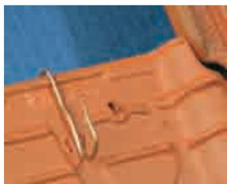
Crochet de tuile visible en cuivre
